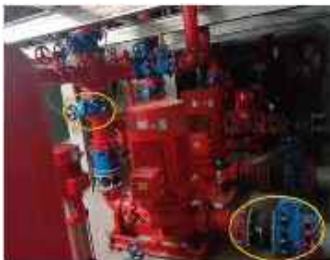
吸水管选用不带锁定装置的蝶阀
