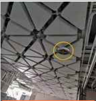
洒水喷头的上方设置挡水板符合要求
